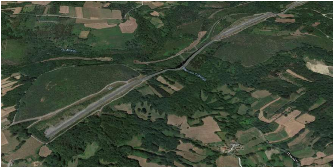
Escombreras del AVE cerca de Donsión (Lalín). Fuente: Google Earth.
